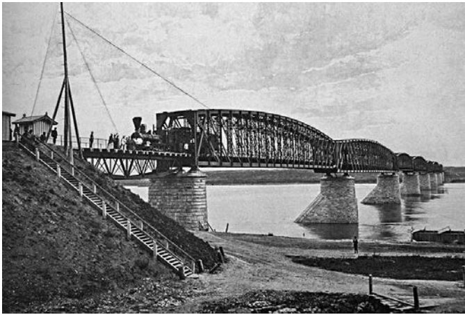
Мост через Обь
