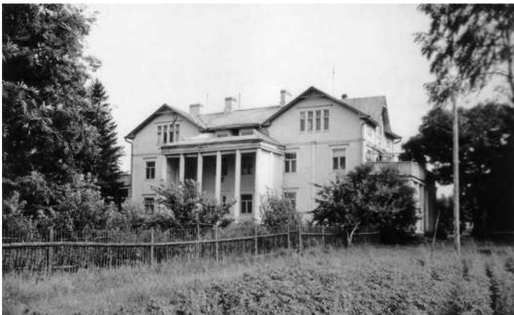
Главный корпус монастыря Новый Валаам с домовою церквю на верхнем этаже
