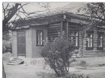
Приемный покой после ремонта
