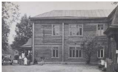
Административный корпус после капитального ремонта
