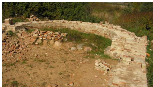
Расчищенный фундамент Покровского храма. 2009 г.
